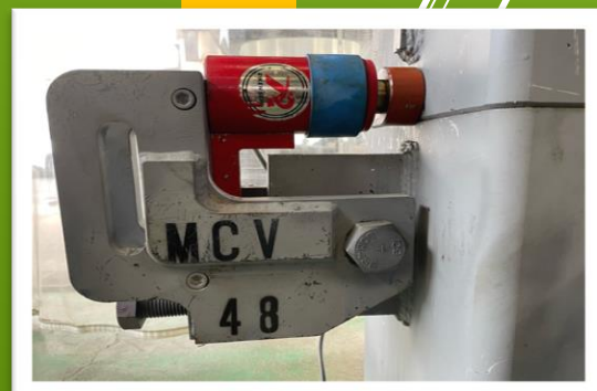
④ジャッキ作動⇒修正完了⇒溶接へ
