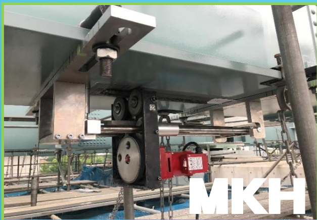
小型支承固定金具切断機 鈑桁用 かち上げ 落下防止に配慮した安全仕様
